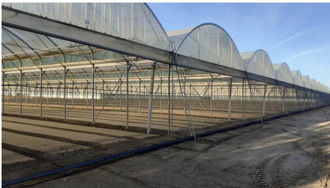
Les serres maraîchères de la SCEA Placier Productions sur le site " Les Courtils " au Loroux-Bottereau
